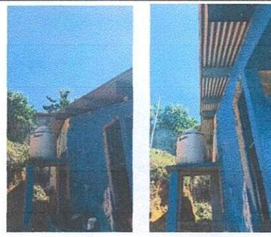
Foto 6: Sustitución de lamina por lamina troquelada
